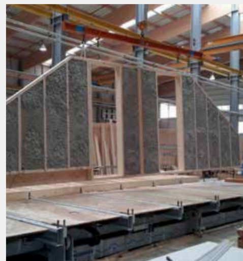
Vláknna v konštrukčnom diele splstnatejú do izolačnej vrstvy na mieru.
